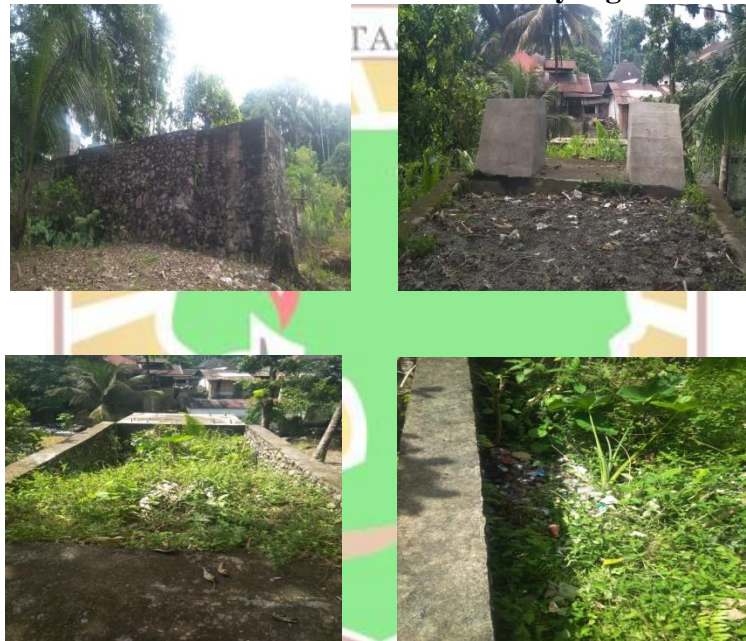
Gambar 1.5 Kondisi Pondasi Jembatan Layang
