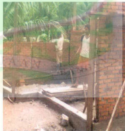
Gambar 6. Dua Orang Tenaga Perusahaan Kontraktor Yang Bekerja
