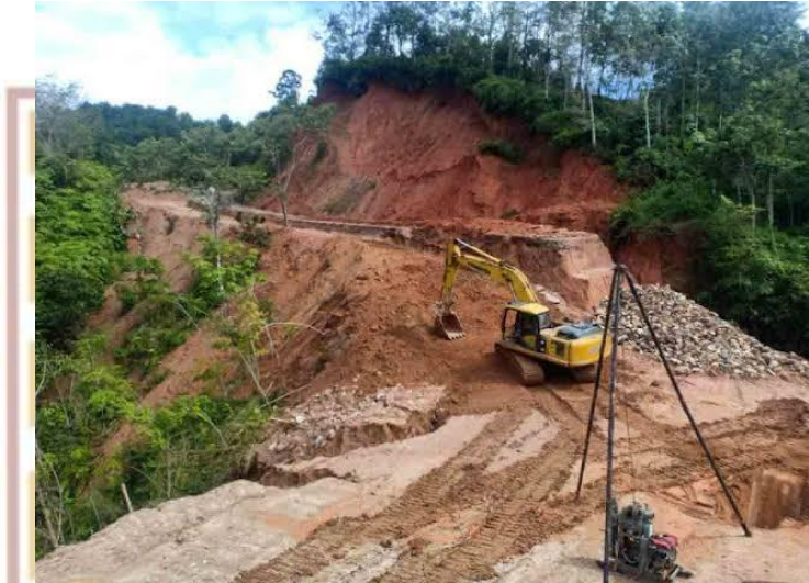
Gambar 1.1 Proyek Perbaikan Jalan Sumpur Kudus, Sijunjung.
