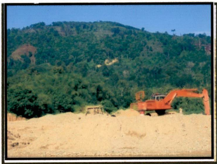
Gambar 5. Penggalian Lubang Tambang dengan Menggunakan Escavator
