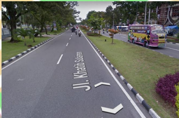
Gambar 1.2 Kondisi jalan Khatib Sulaiman sebelum dilakukannya rehabilitasi jalan (Sumber : Google Earth )
