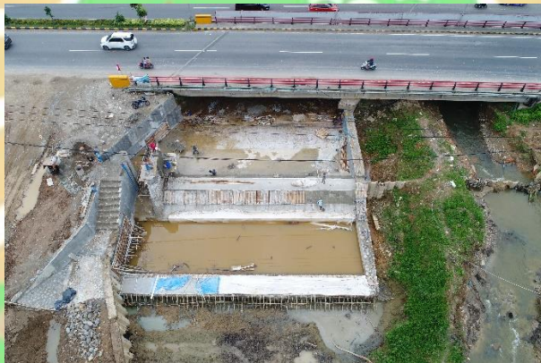
Gambar 1.2 Pembangunan Pengendalian Banjir
