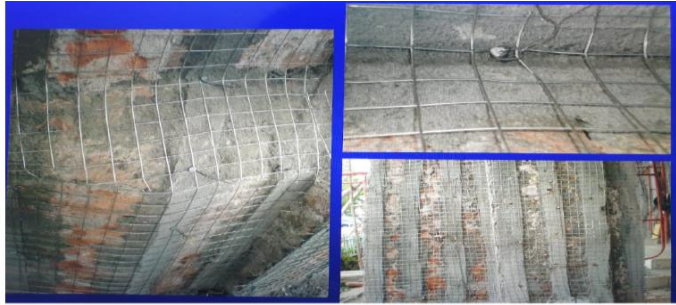
Gambar 4.21 Pemasangan kawat Anyam, Angkur, Paku pada Dinding
