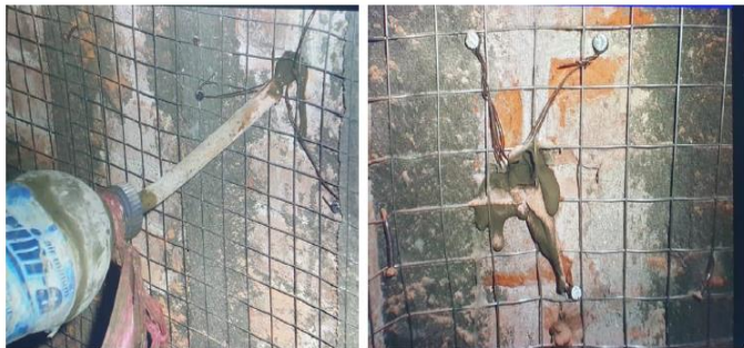
Gambar 4.22 Pengisian bekas lubang bor dengan Pasta semen
