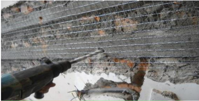
Gambar 4.18 Pemasangan Angkur Kawat Anyam
