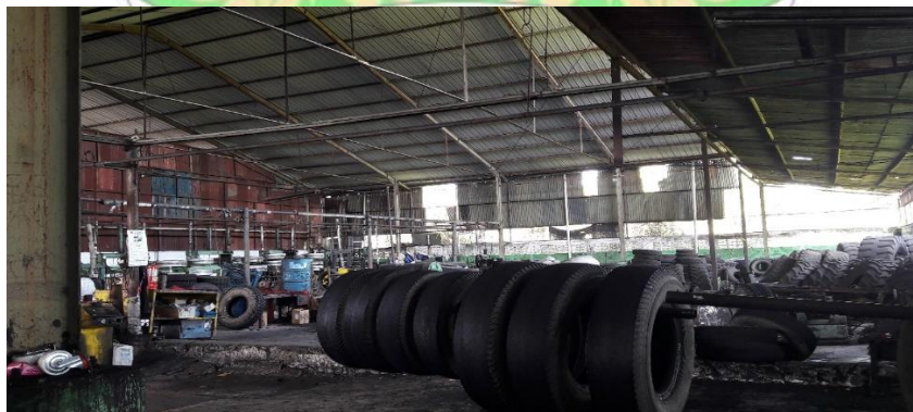
Gambar 1.3 Kondisi Bangunan pada PT Inti Vulkatama
