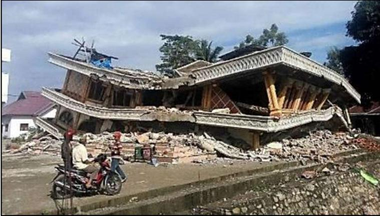
**Gambar 1.3** Keruntuhan bangunan struktur rangka beton bertulang dengan bukaan pada dinding saat gempa Aceh Desember 2016
