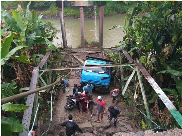
Gambar 1.2 Dokumentasi Jembatan Sikabu Ambruk
