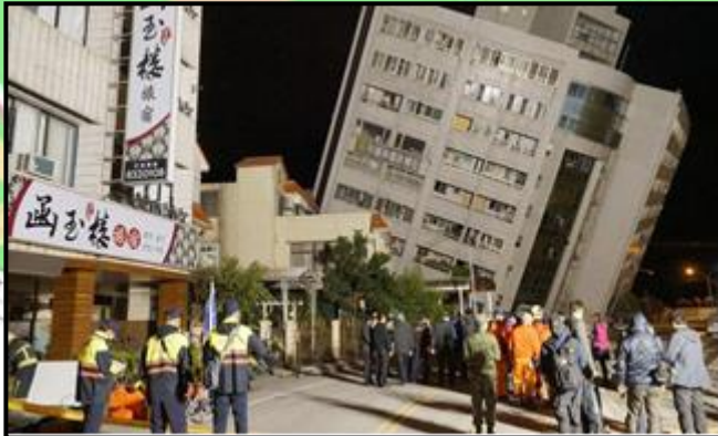
Gambar 1.1 Kerusakan gedung akibat gempa bumi
