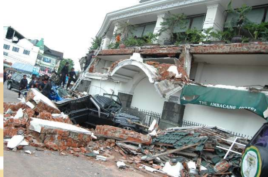
Gambar 1.1 Kerusakan pasca gempa bumi padang 2009
