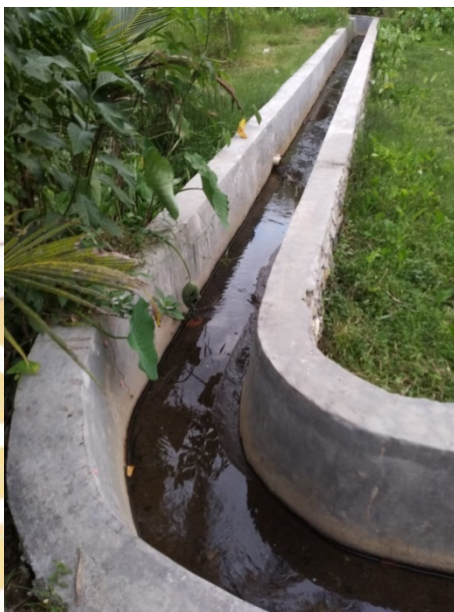
Gambar 4.29 Perbaikan Saluran Air di Nagari Campago
