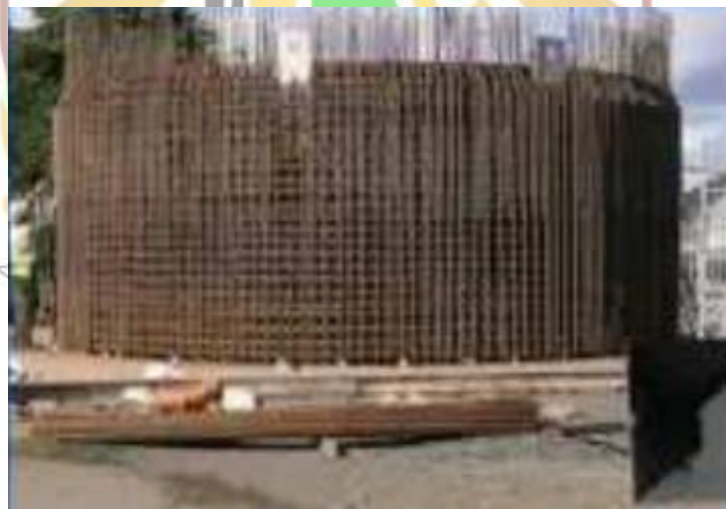
Gambar 1.2 Struktur Bangunan Dengan Tulangan Rapat
