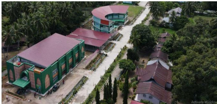
Gambar 1.5 Pembangunan MAN Insan Cendekia Padang Pariaman
