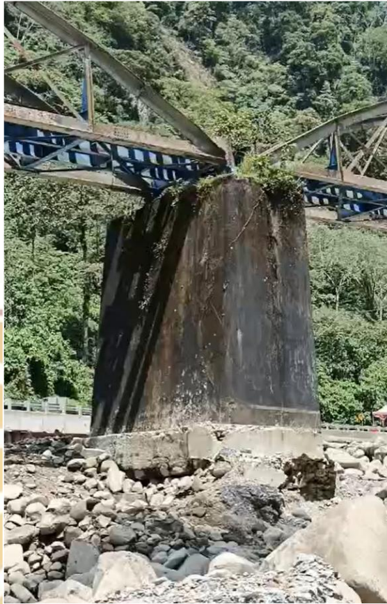
Gambar 1.1 Kondisi eksisting pilar jembatan
