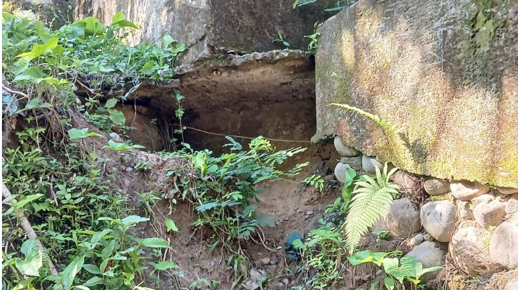
Gambar 15. Penurunan pada Tanah Timbunan (NK.2)
