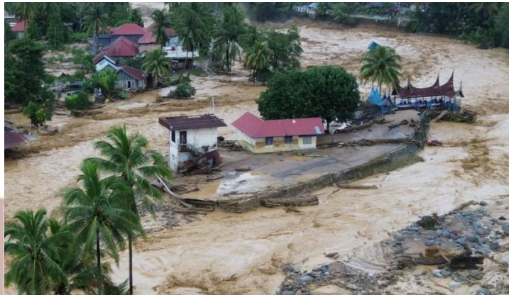
Gambar 1. 1 Kondisi Jembatan Gunuang Nago
