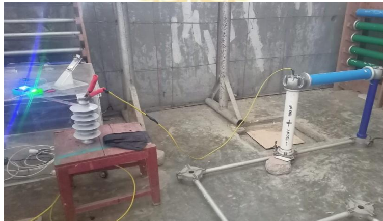
Gambar 4. 1 Proses Pengambilan Data Emisi Akustik Corona discharge di Laboratorium Teknik Tegangan Tinggi
