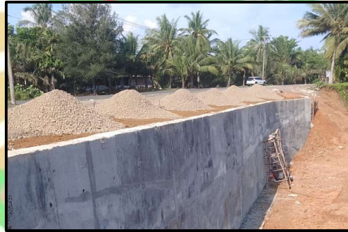
Gambar 4. 17 Pekerjaan Timbunan Pilihan
