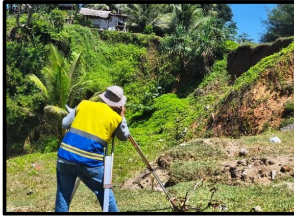
Gambar 4.3 Pengukuran dan Setting Out
