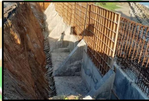
Gambar 4. 14 Pekerjaan Dinding Penahan Tanah Tahap Kedua
