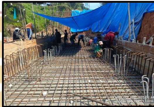
Gambar 4. 11 Pemasangan Tulangan Pile Cap
