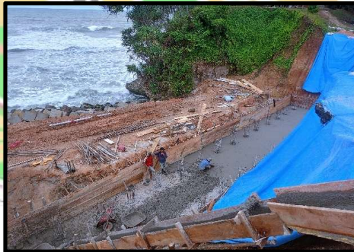
Gambar 4. 10 Pengecoran Lantai Kerja
