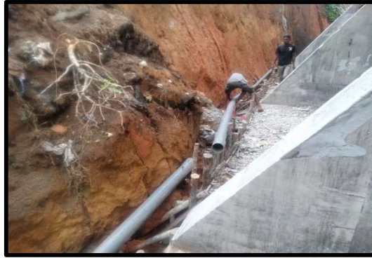
Gambar 4. 15 Pekerjaan Pipa Perporated
