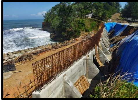
Gambar 4. 14 Pekerjaan Dinding Penahan Tanah Tahap 1
