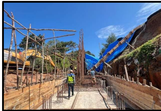
Gambar 4. 12 Pemasangan Bekisting Pile Cap
