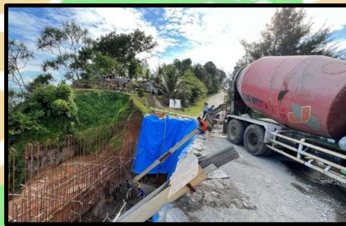
Gambar 4. 13 Pengecoaran Pile Cap
