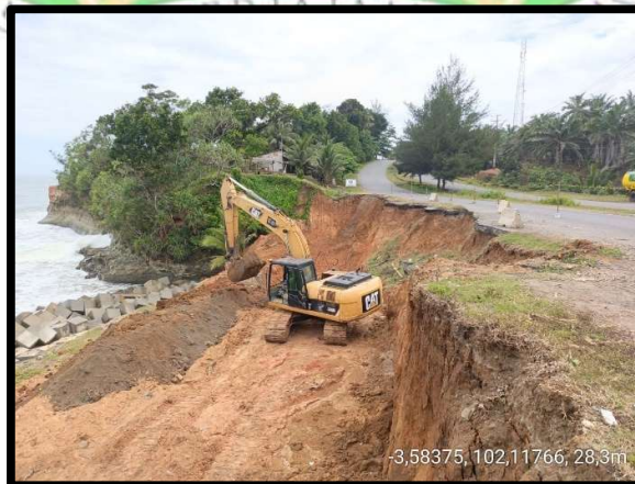
Gambar 4.4 Pekerjaan Galian Tanah
