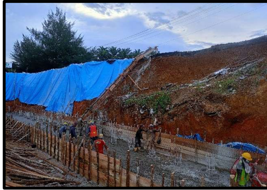
Gambar 4. 9 Pemasangan Bekisting Lantai Kerja
