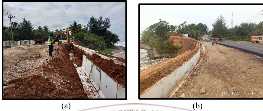
Gambar 4. 18 Pekerjaan Pemasangan Saluran Berbentuk U Tipe DS 3 (a) Pemasangan dengan bantuan excavator , dan (b) Saluran U telah terpasang
