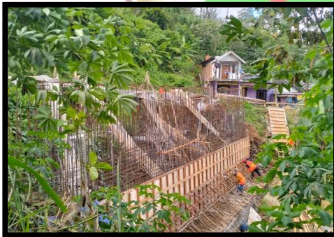
Gambar 4 7 Pekerjaan RWC Tahap 1
