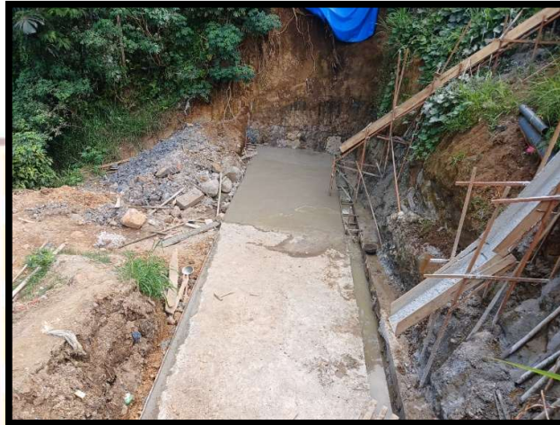
Gambar 4 5 Pekerjaan lantai kerja
