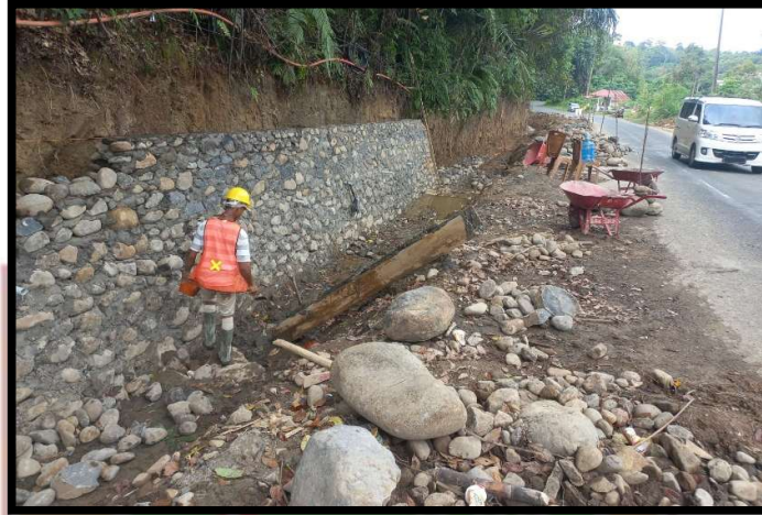
Gambar 4 12 Pasangan Batu dengan Mortar
