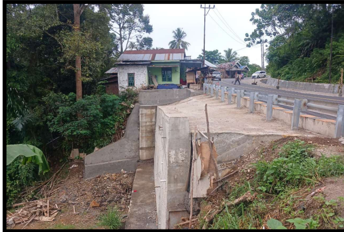
Gambar 4 13 Beton Penutup Timbunan
