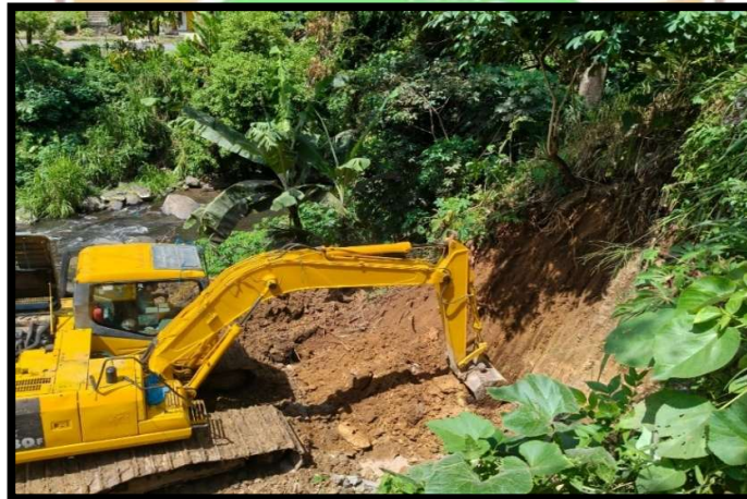
Gambar 4 4 Pekerjaan Tanah galian dan timbunan
