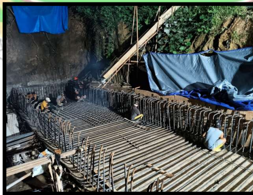
Gambar 4 6 Pekerjaan Pile Cap
