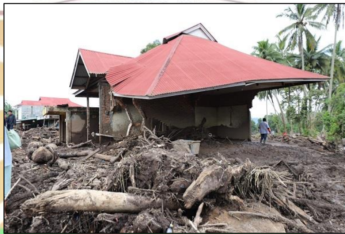
Gambar 1. 2 Kondisi Salah Satu Rumah yang Terdampak
