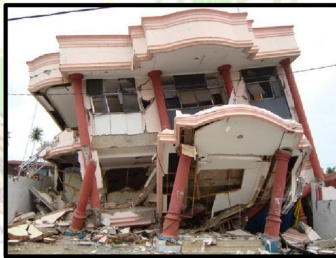
Gambar 1.1 Kerusakan struktur akibat gempa
