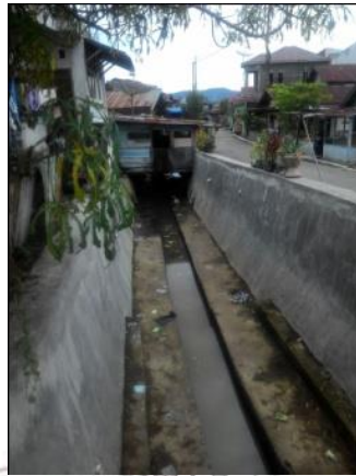
Gambar 1. 5 Kondisi Drainase dalam Program Kotaku Pada Tahun 2017
