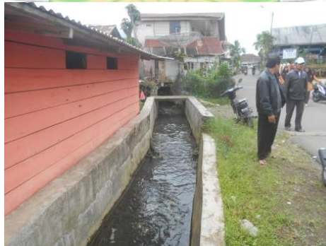
Gambar 1. 11 Kondisi Drainase dalam Program Kotaku Pada Tahun 2017
