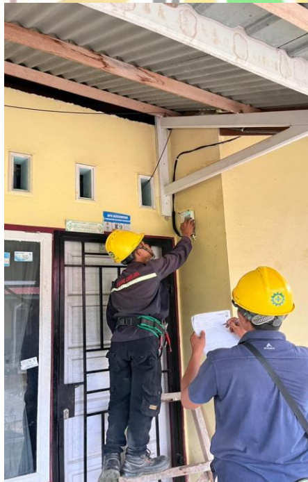
Gambar 4.7 pemasangan meteran baru
