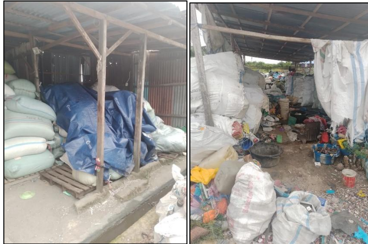
Gambar 4. 22 Penggunaan Kanopi Kayu Atap Seng pada Area GILPLAS Sumbar
