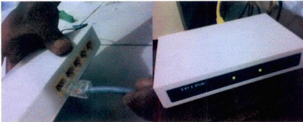
Gambar IV.4 Pemasangan Kabel UTP pada hub
