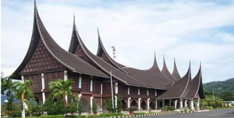
Gambar 1.1 Konstruksi Atap Bagonjong
