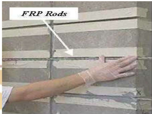
Gambar 1.8 Perkuatan dengan Fiber-Reinforced Polymer (FRP) (Sumber: Tumialan, 2002)
