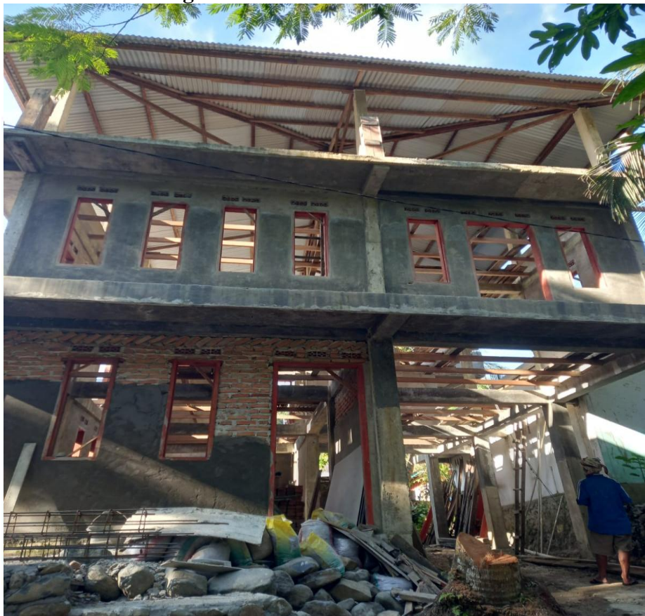
Gambar 4. Perluasan Bangunan Pesantren Akhwat di rumah Darussalam
