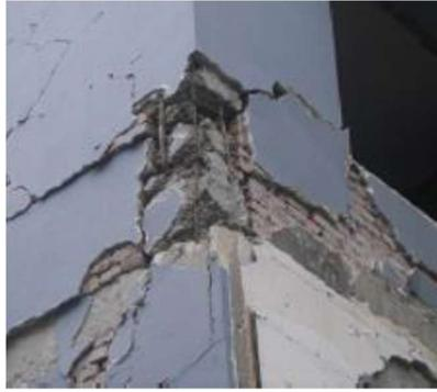
**Gambar 1. 1** Kerusakan pada join balok kolom lantai 2, Dujingan City, ketika Gempa Wenchuan, 2008 (Shivakumara Swamy et.al, 2015)
