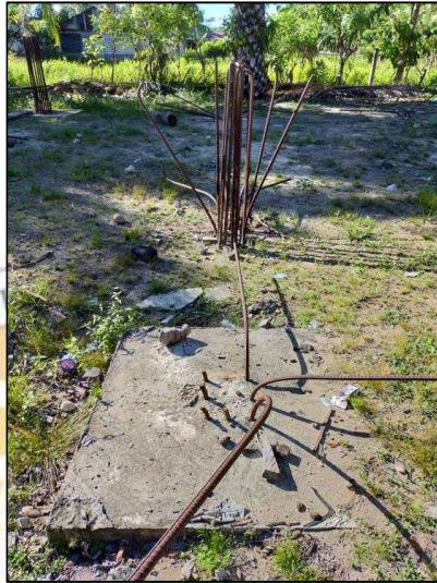
Gambar 1.1 Tulangan stek kolom sudah dipotong
