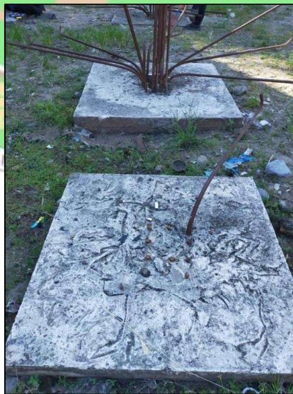
Gambar 1.2 Pile cap pondasi dengan stek tulangan kolom sudah habis dipotong
