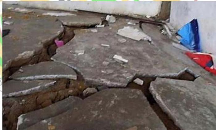
**Gambar 1.5** Terangkatnya plat lantai di kawasan perumahan Perumdam, Padang (Chian et al., 2019)
