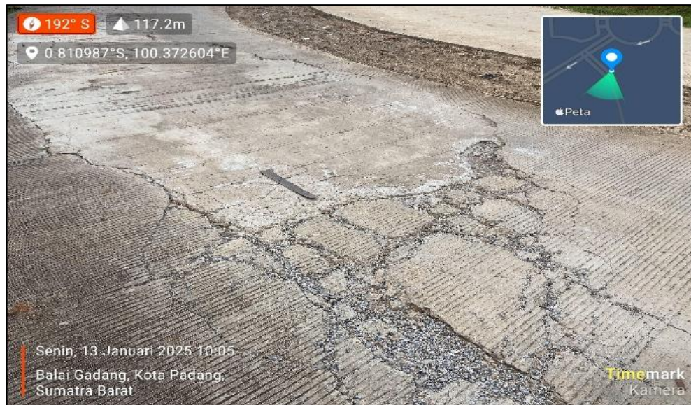
Gambar 1. 2 Fraktur Struktural pada Lapisan Perkerasan Rigid di Area Kampus UIN Imam Bonjol Padang
