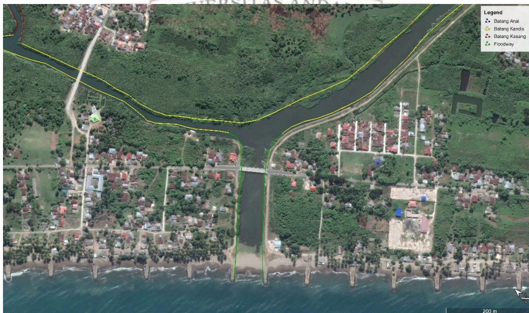
Gambar 1. 4 Kondisi Batang Kandis tertutup sedimen pada tahun 2016 (Google Earth, 2025)
