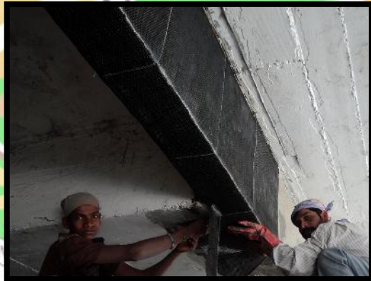
Gambar 1.5 Penambahan Serat Karbon Pada Balok (Sumber : http://www.svc92.com/Structural-Rehabilitation.html )
