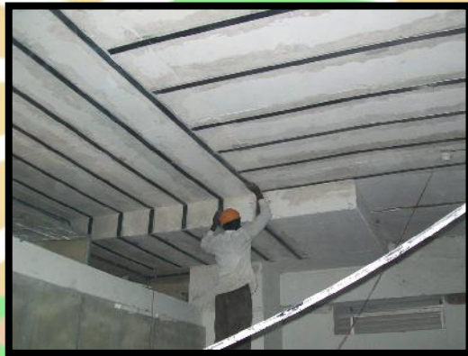
Gambar 1.6 Penambahan Baja Pada Plat Lantai (Sumber : http://www.svc92.com/Structural-Rehabilitation.html )
