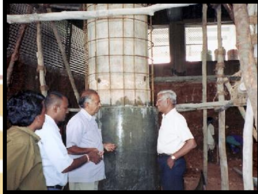
Gambar 1.4 Metode Jacketing Pada Kolom (Sumber : http://www.svc92.com/Structural-Rehabilitation.html )
