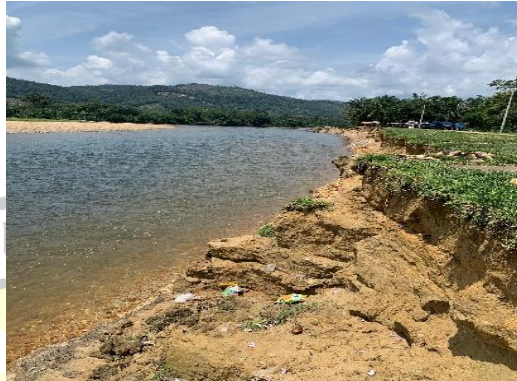
Gambar 1.4 Longsor/ablasi pada bibir sungai
