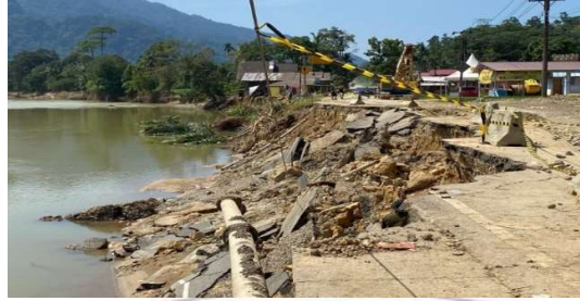
Gambar 1.1 Keruntuhan pada lereng ruas Jl. KM.45+400
