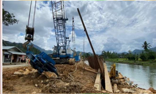
Gambar 1.2 Metode perbaikan pada ruas jalan KM.45+400
