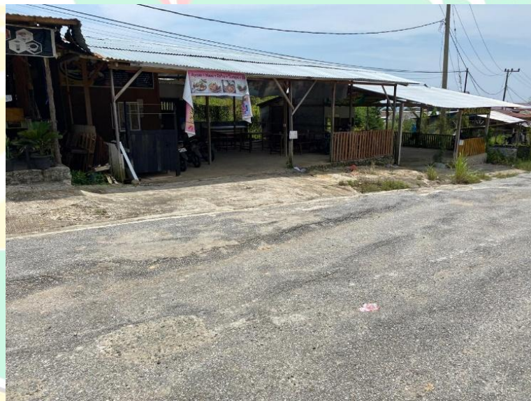
Gambar 1. 3 Perkerasan Lentur yang Bergelombang di Jalan Kampus III UIN Imam Bonjol
