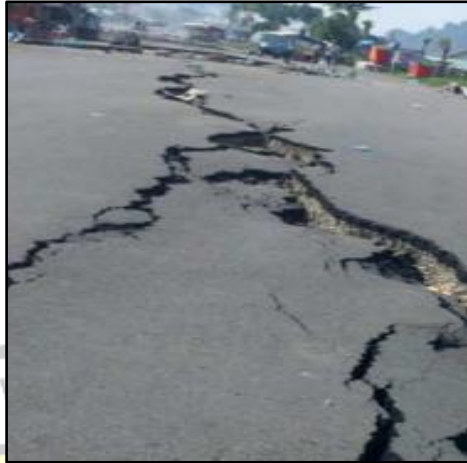
Gambar 1. 2 Retakan tegangan yang timbul akibat penyebaran lateral di Siteba, Padang
