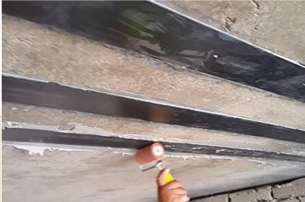
Gambar 1. 1 Contoh Pemasangan CFRP pada elemen Pelat lantai.
