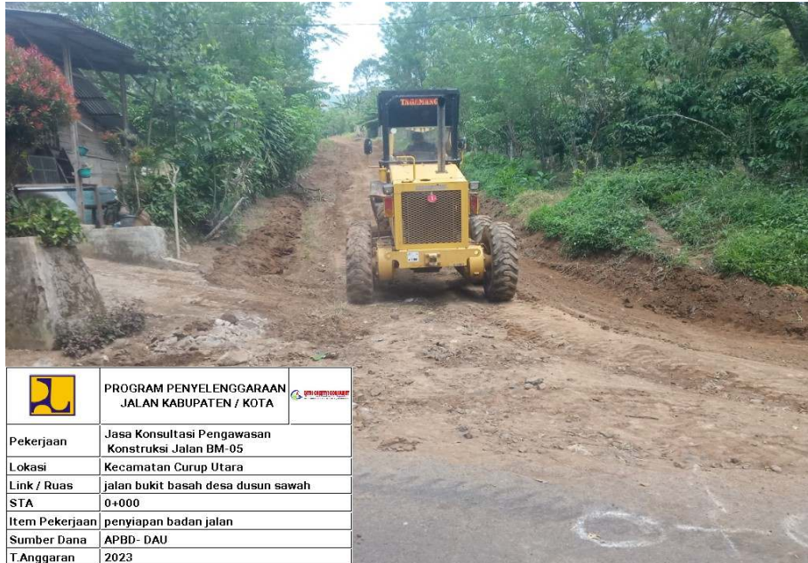
Gambar 4.2 Pembersihan dan penggarukan jalan
