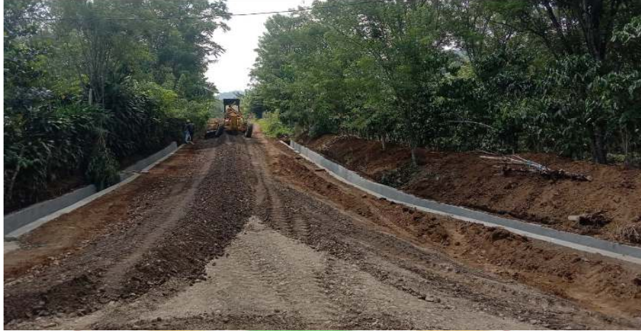
Gambar 4.6 Penghamparan agregat kelas B
