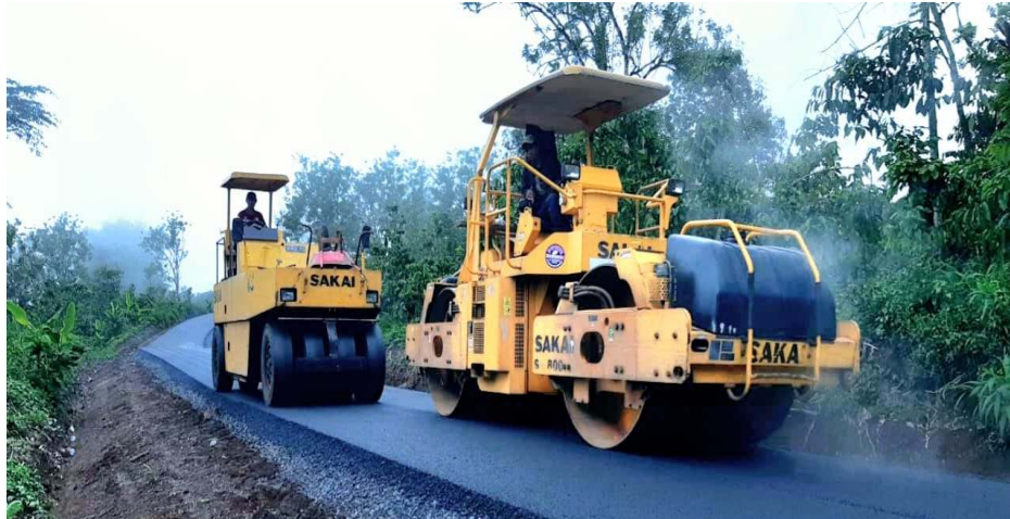
Gambar 4.16 Pematatan dengan Tandem Roller dan penghalusan dengan Pneumatic Tyre Roller
