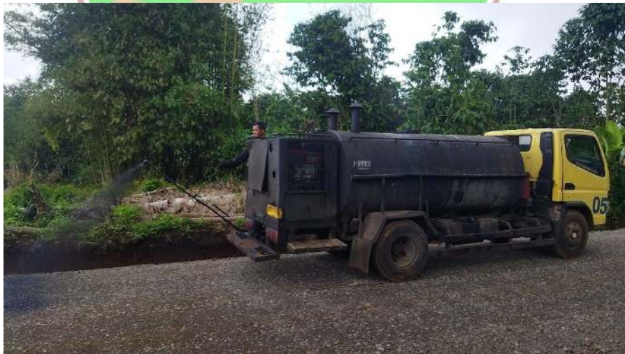
Gambar 4.8 Penyemprotan lapis resap pengikat
