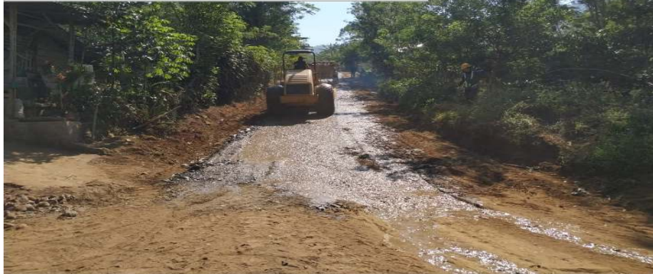
Gambar 4.4 Timbunan pilihan
