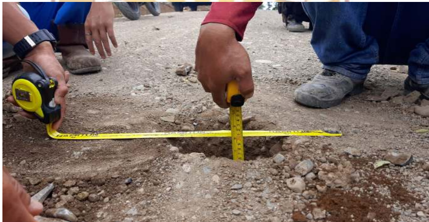
Gambar 4.5 Ketebalan timbunan pilihan
