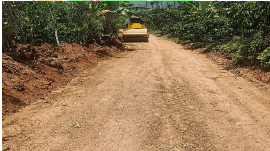
Gambar 4.3 Pemasatan badan jalan
