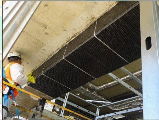
Gambar 1. 1 Struktur dengan Perkuatan CFRP
