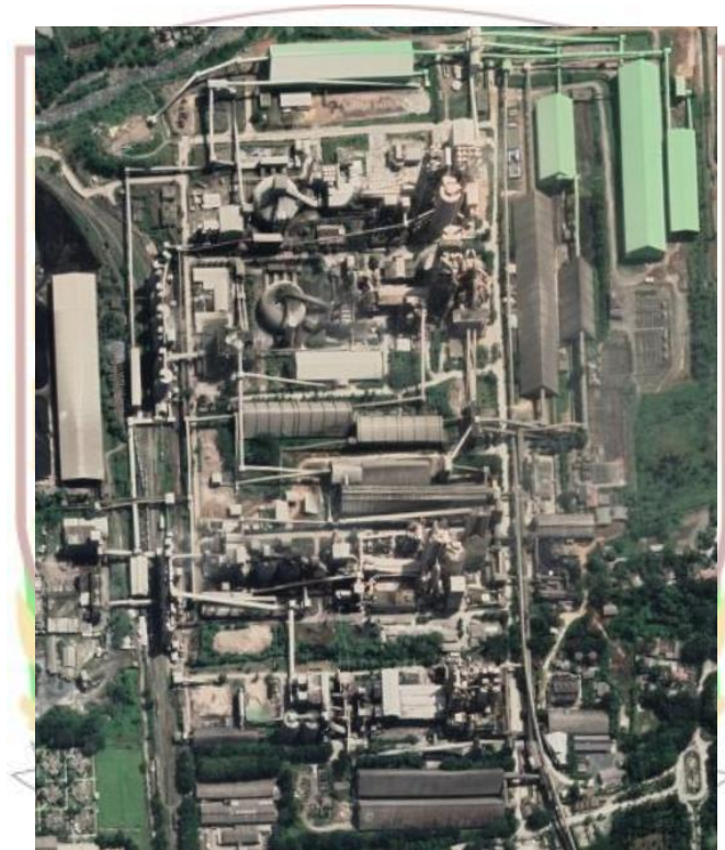
Gambar 3. 2 Lokasi pabrik Indarung VI PT. Semen Padang
