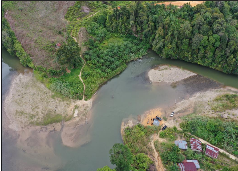
Gambar 3.3. Dokumentasi Kondisi Eksisting Jembatan
