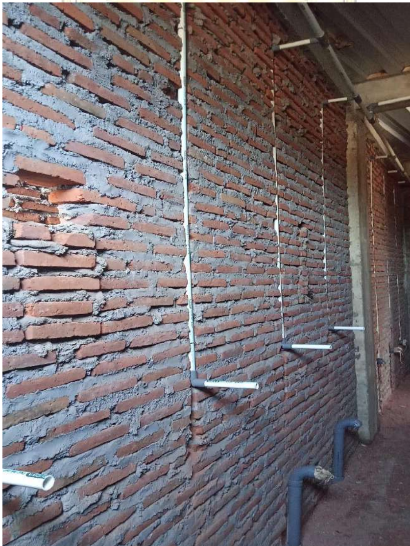
Lampiran 9. Pekerjaan pemasangan pipa bersih toilet
