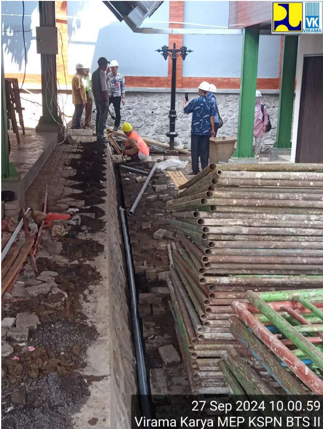
Lampiran 7. Saluran pipa distribusi air bersih kawasan
