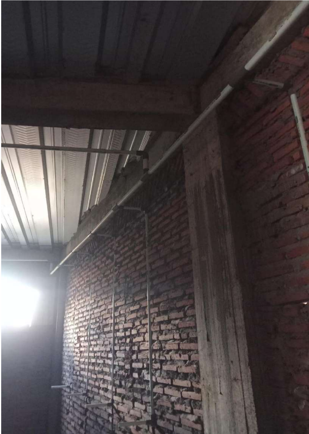
Lampiran 10. Pekerjaan pemasangan pipa bersih toilet
