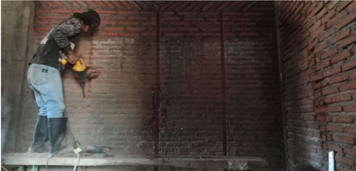
Lampiran 8. Pekerjaan bobokan pipa bersih toilet
