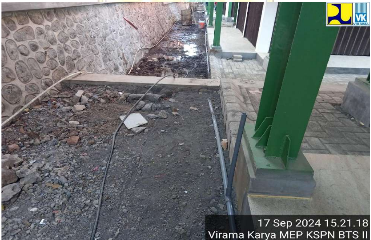
Lampiran 6. Saluran pipa distribusi air bersih kawasan
