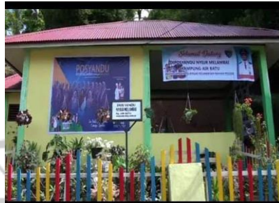
Gambar 1.3 Pembangunan Fisik Posyandu Nagari Pelangai
