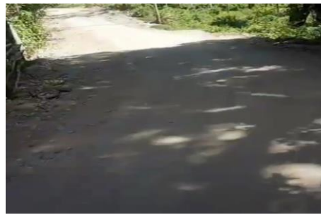
Gambar 1.4 Pembangunan Jalan Nagari Pelangai
