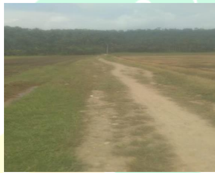
Gambar 1.2 Pembangunan Jalan Tani Nagari Pelangai
