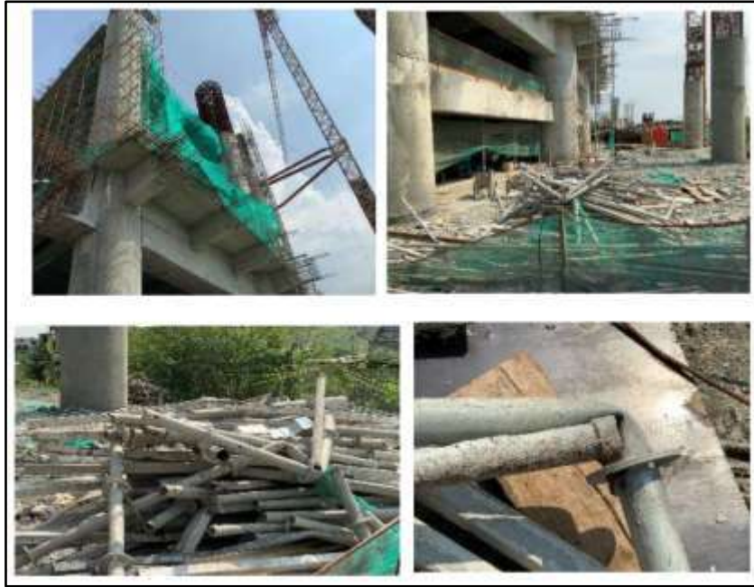
Gambar 1.1 proyek konstruksi Jakarta International Stadium (JIS)
