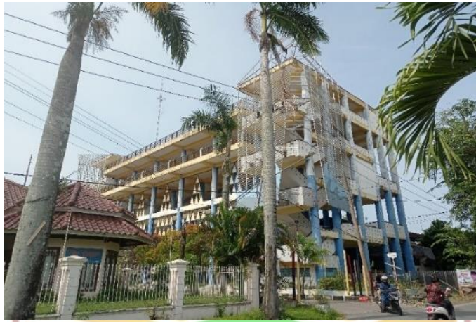
Gambar 1. 1: Gedung Tempat Evakuasi Sementara (TES) Shelter Ulak Karang
