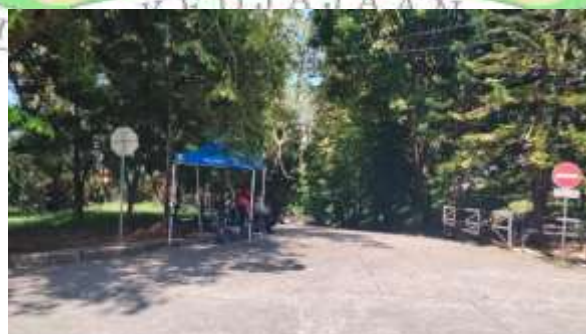
Gambar 1. 3 Kondisi Awal Portal Gedung Farmasi
