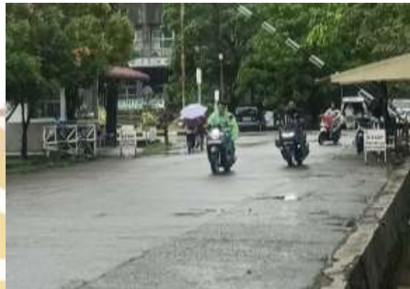
Gambar 1. 1 Kondisi Awal Portal Gedung E
