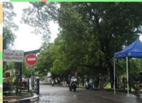
Gambar 1. 2 Kondisi Awal Portal Gedung I
